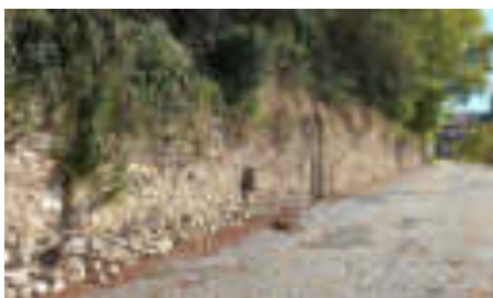
Muretti danneggiati da risalire attraverso interventi di cuci e scuci
